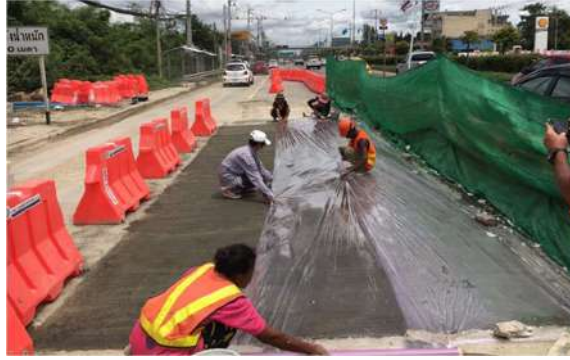
รูปที่ 5.52 ปิดทับผิวคอนกรีตด้วยพลาสติกเพื่อบ่มคอนกรีตจนได้กำลังรับแรงอัด
