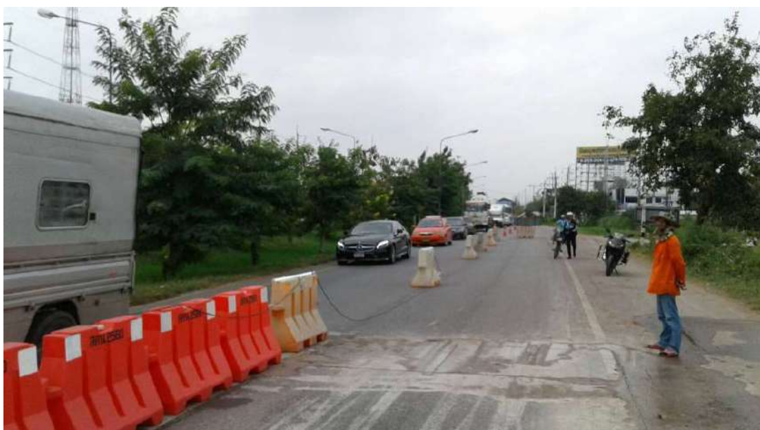
รูปที่ 5.67 การปิดการจราจร 1 ช่องทางซ้ายสุดสำหรับแปลงตรวจวัดโครงสร้างถนนลาดยาง
