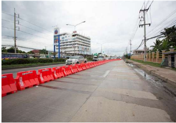
รูปที่ 5.5 การปิดการจราจร 2 ช่องทางซ้ายสุดสำหรับแปลงตรวจวัดโครงสร้างถนนคอนกรีต
