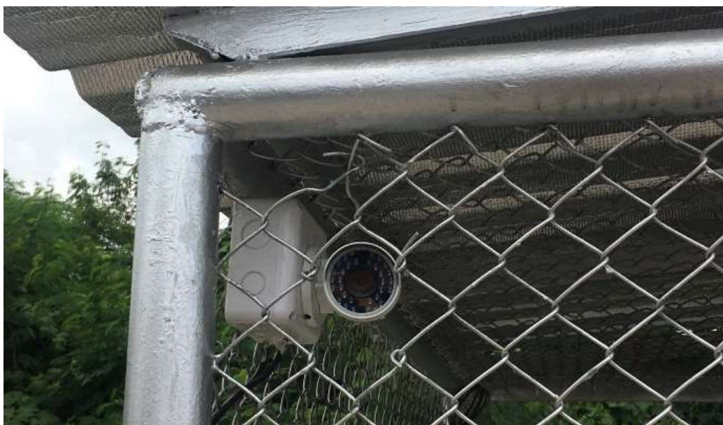
รูปที่ 5.63 การติดตั้งกล้องวงจรปิด แปลงตรวจวัดโครงสร้างถนนคอนกรีต
