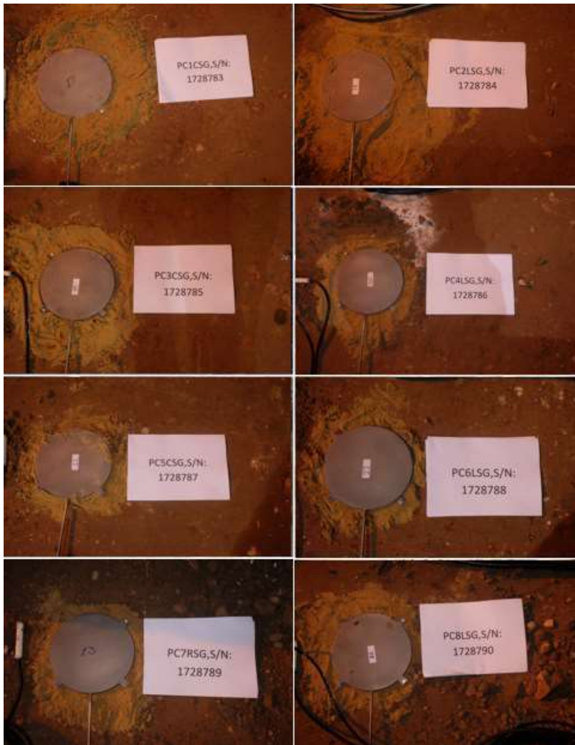
รูปที่ 5.79 งานติดตั้งอุปกรณ์ตรวจวัดค่าแรงดัน (Pressure Cell) ในชั้น Subgrade
