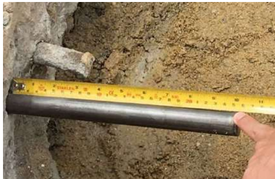
รูปที่ 5.40 ติดตั้งเหล็กเดือย (Dowel Bar) ฝังในรอยต่อตามขวางของถนน ด้านละ 25 ซม.
