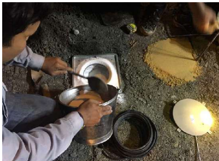
รูปที่ 5.19 การทดสอบความแน่นของวัสดุในสนามโดยใช้ทราย (Field Desity Test) ในชั้น Subgrade
