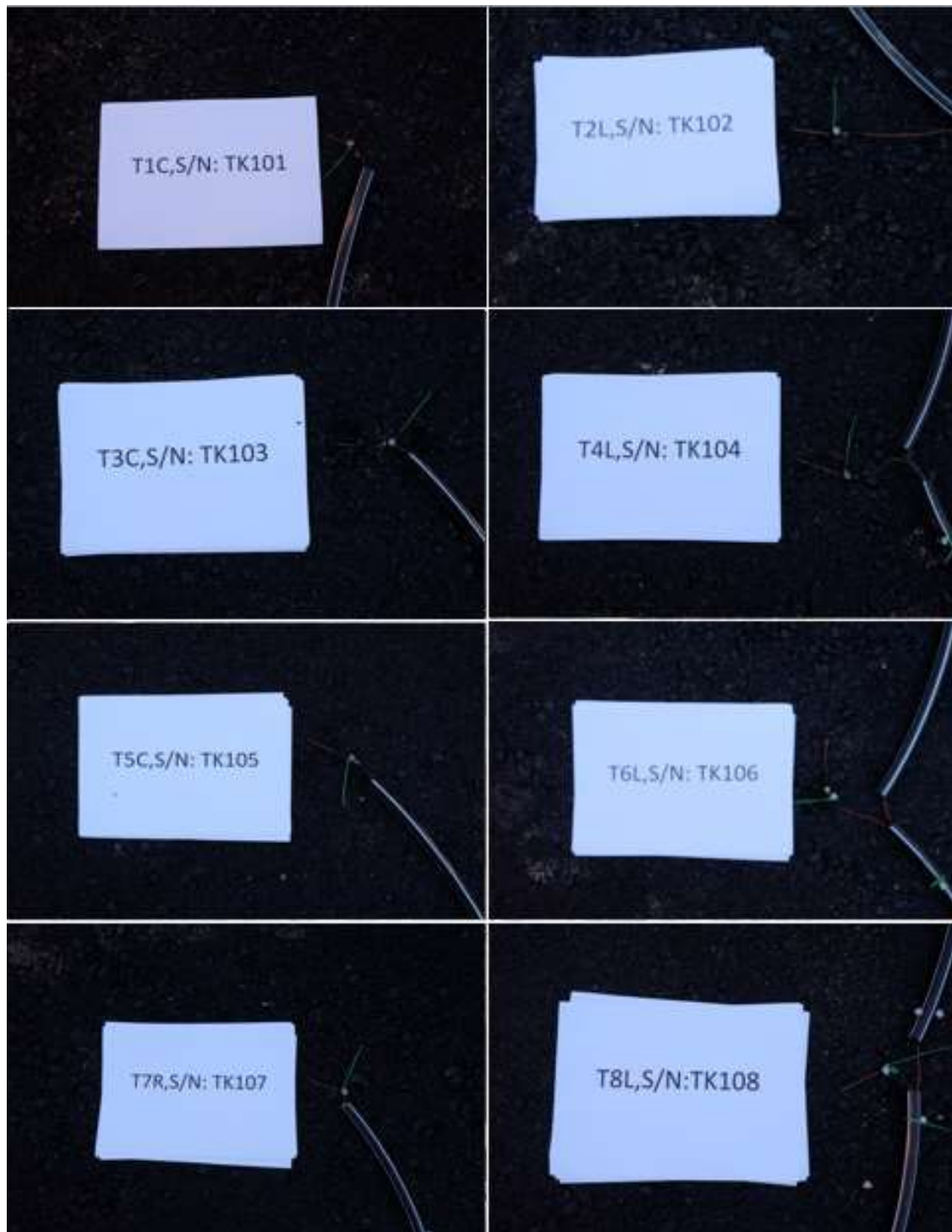
รูปที่ 5.93 งานติดตั้งอุปกรณ์ตรวจวัดค่าอุณหภูมิ (Thermocouple) ในชั้น AC Surface
