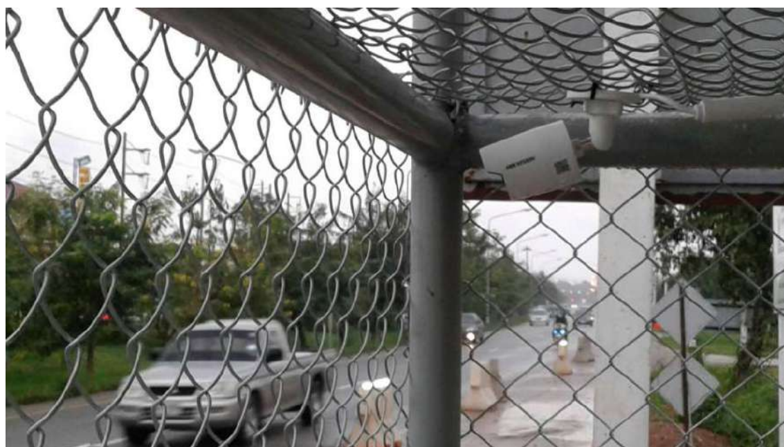
รูปที่ 5.109 การติดตั้งกล้องวงจรปิดแปลงตรวจวัดโครงสร้างถนนลาดยาง
