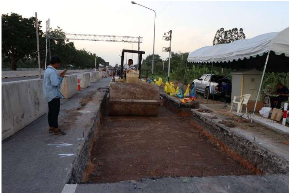
รูปที่ 5.124 งานบดอัดชั้น Subgrade
