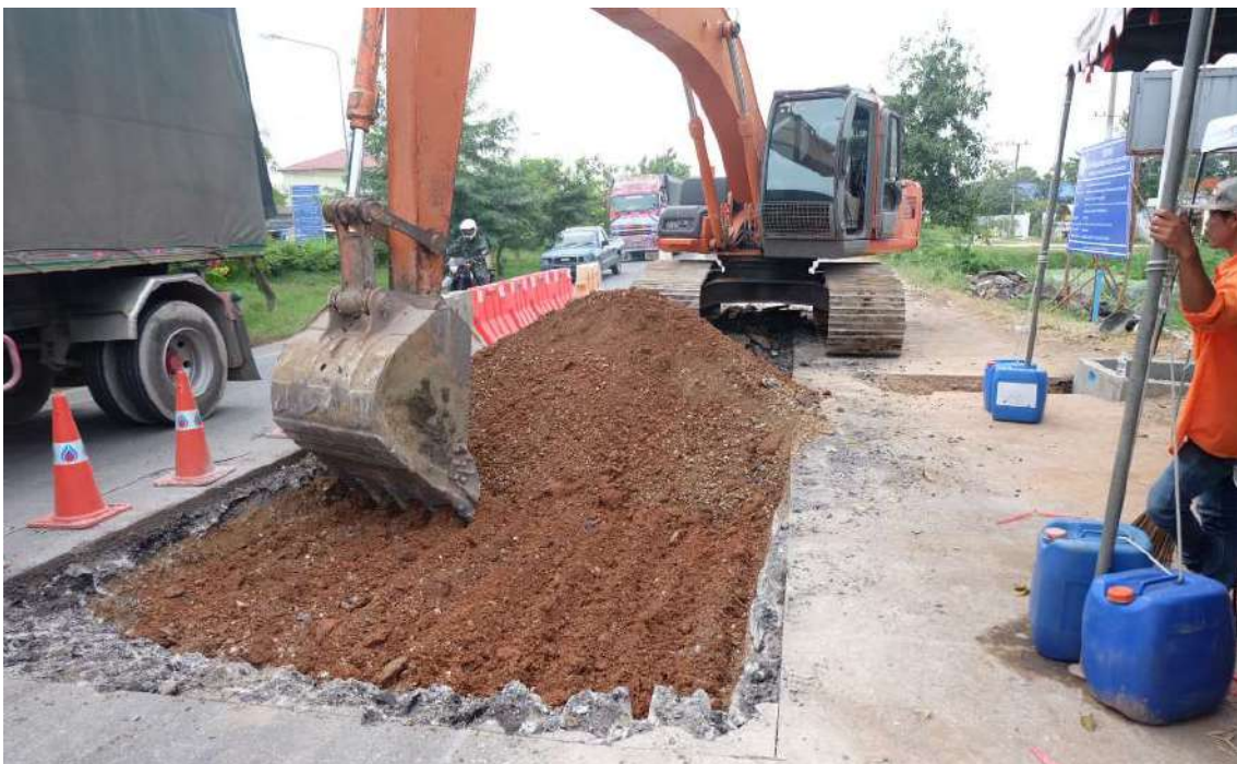
รูปที่ 5.72 งานขุดรื้อโครงสร้างชั้นทางจนถึงชั้น Subgrade
