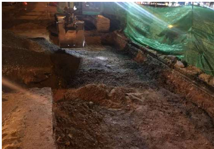
รูปที่ 5.15 งานขุดรื้อชั้น Sand Cushion, Subbase, Selected Material จนถึงชั้น Subgrade (3)
