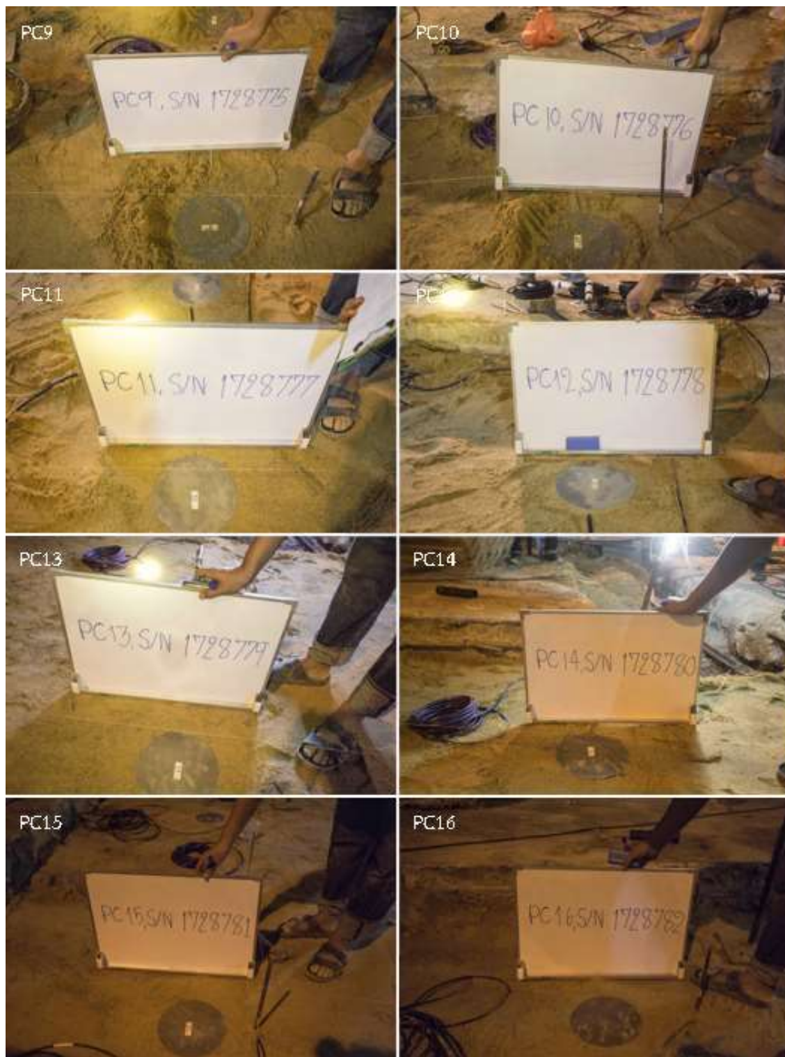
รูปที่ 5.33 งานติดตั้งอุปกรณ์ตรวจวัดค่าแรงดัน (Pressure Cell) ในชั้น RC Surface
