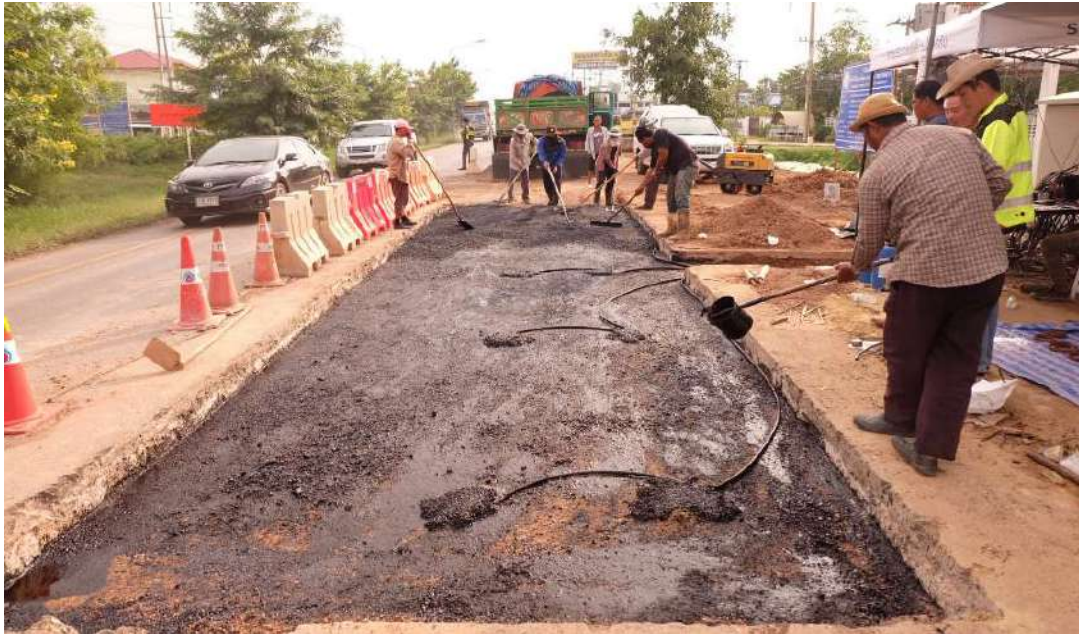
รูปที่ 5.96 ชั้น Prime Coat
