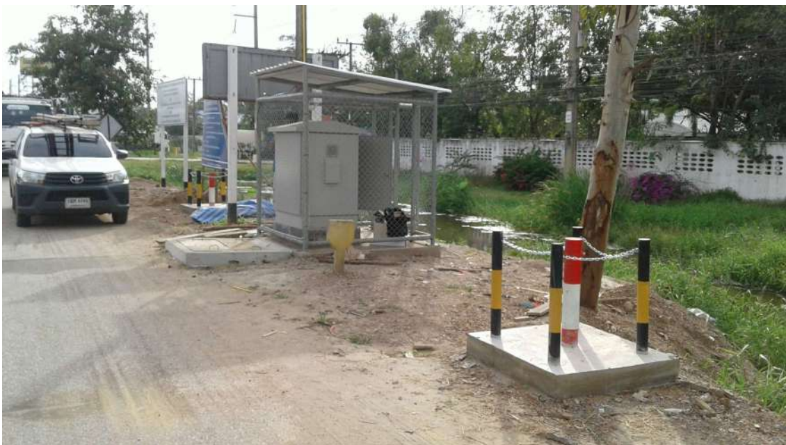
รูปที่ 5.101 เทพื้นคอนกรีตบริเวณรอบหลุมเจาะจำนวน 2 จุดแปลงตรวจวัดโครงสร้างถนนลาดยาง
