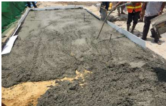
รูปที่ 5.48 การใช้เครื่องสั่นคอนกรีต (Concrete Vibrator) เพื่อให้ส่วนผสมคอนกรีตแน่น
