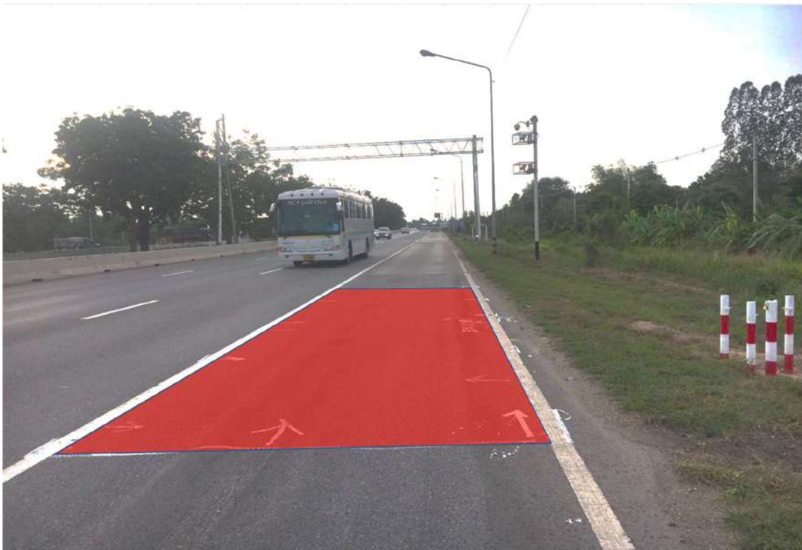
รูปที่ 4.24 บริเวณแปลงโครงสร้างถนนลาดยางก่อนถึงบริเวณเครื่องชั่ง WIM สรรพยา (ขาเข้า)
