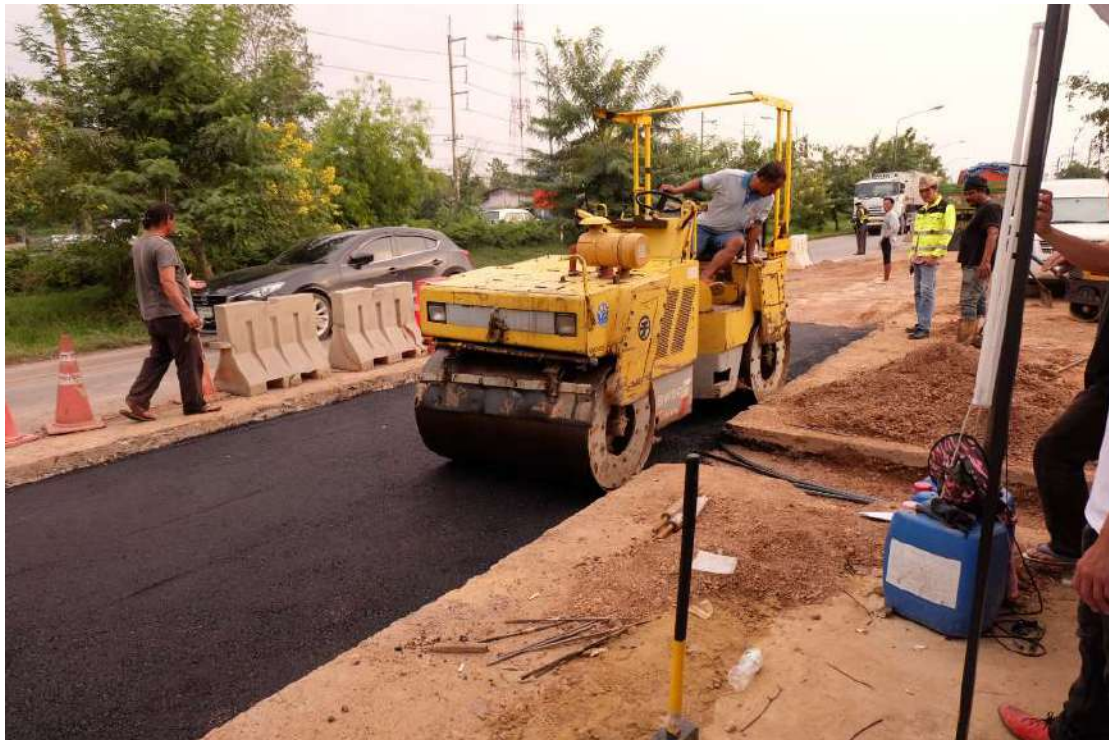
รูปที่ 5.97 ชั้น Asphalt Concrete Binder Course
