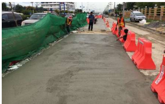
รูปที่ 5.50 เทปาดระดับผิวคอนกรีตให้เสมอรระดับผิวถนนคอนกรีตที่อยู่โดยรอบ
