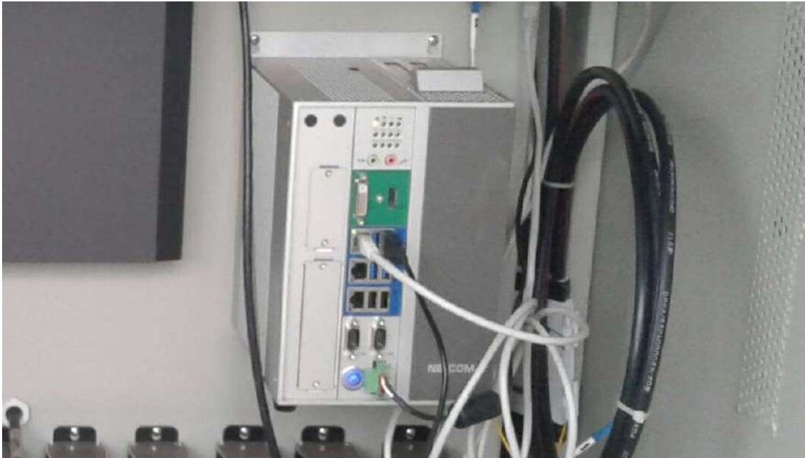
รูปที่ 5.110 การติดตั้งหน่วยประมวลผลภาคสนามแปลงตรวจวัดโครงสร้างถนนลาดยาง
