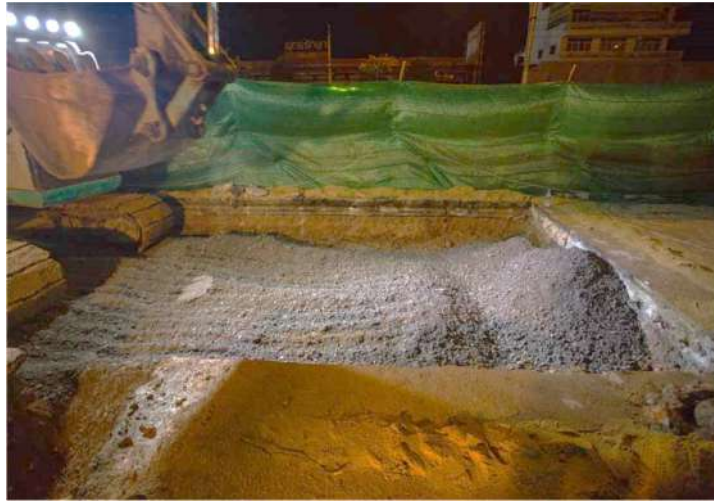
รูปที่ 5.16 งานปรับระดับชั้น Subgrade เดิม
