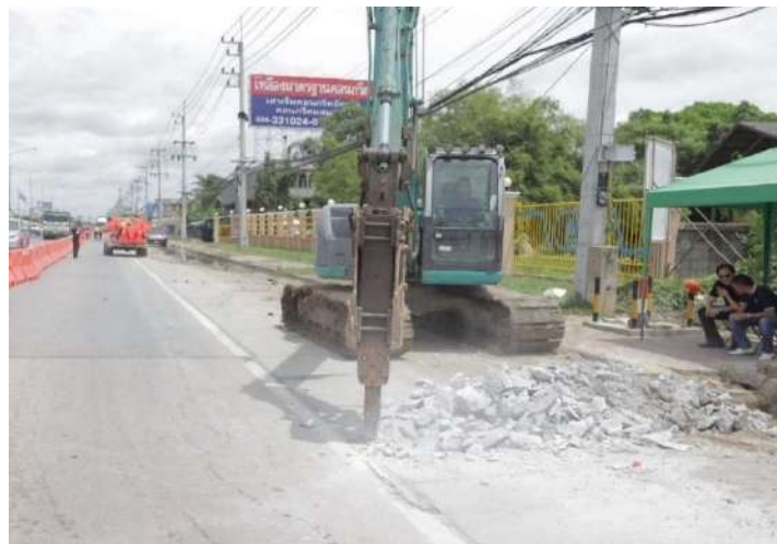
รูปที่ 5.10 งานเจาะสกัดรื้อผิวทางคอนกรีต บริเวณช่องจราจรที่ 1
