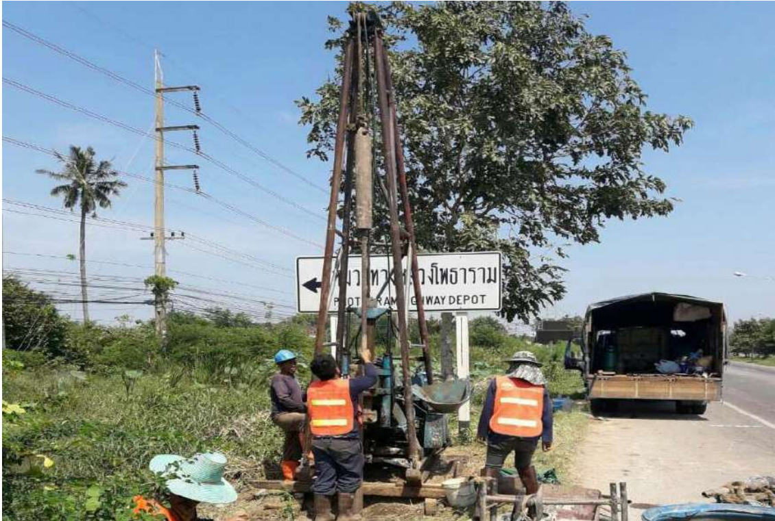
รูปที่ 5.100 ขุดหลุมเจาะ ลึกขนาด 15 เมตร จำนวน 2 จุด แปลงตรวจวัดโครงสร้างถนนลาดยาง
