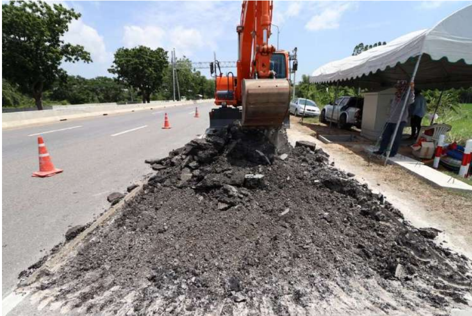
รูปที่ 5.122 งานขุดรื้อผิวทางและโครงสร้างชั้นทางช่องจราจรที่ 1
