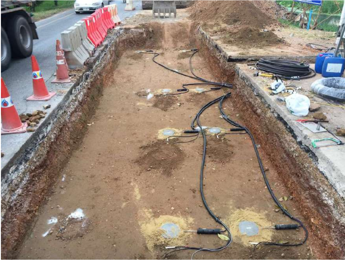
รูปที่ 5.81 งานเดินสายสัญญาณของอุปกรณ์ตรวจวัดจำนวน 24 ตัว ในชั้น Subgrade ลงท่อ PE
