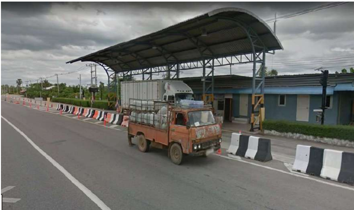
รูปที่ 4.22 บริเวณด้านหน้าสถานีตรวจสอบน้ำหนักรถบรรทุก (ขาเข้า)
