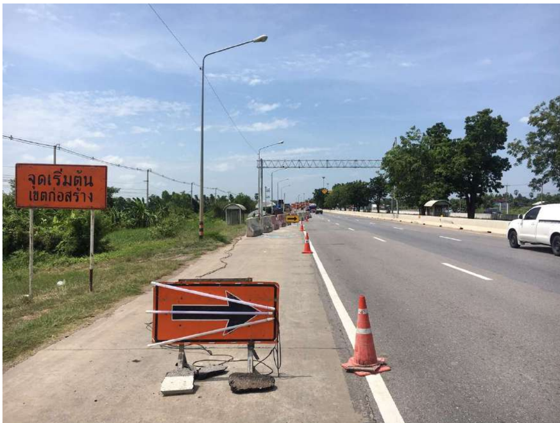
รูปที่ 5.119 การติดตั้งป้ายจราจรสำหรับแปลงตรวจวัดโครงสร้างถนนลาดยาง
