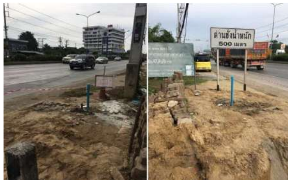
รูปที่ 5.54 ติดตั้งท่อ PVC ในหลุมเจาะ จำนวน 2 จุด แปลงตรวจวัดโครงสร้างถนนคอนกรีต
