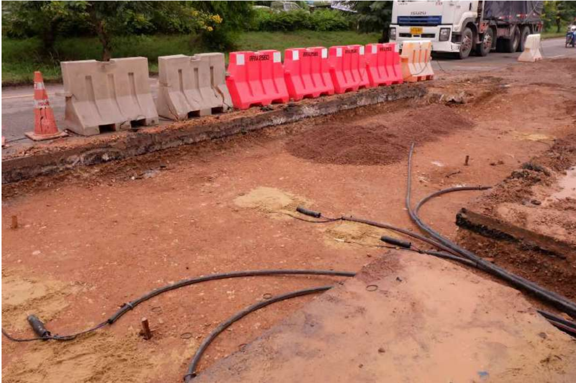
รูปที่ 5.86 งานเดินสายสัญญาณของอุปกรณ์ตรวจวัด ในชั้น Base ลงท่อ PE
