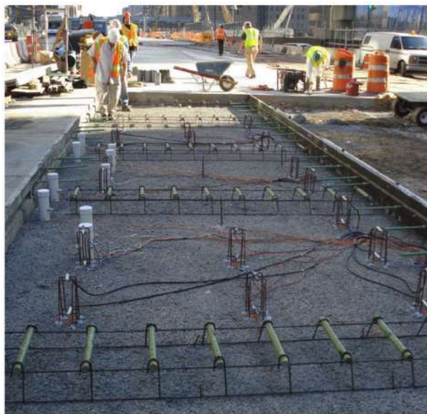
รูปที่ 3.19 ตัวอย่างภาพการติดตั้งอุปกรณ์ตรวจวัดพฤติกรรมและการตอบสนองของรัฐนิวยอร์ก (ที่มา : Sargand et al., 2012)
