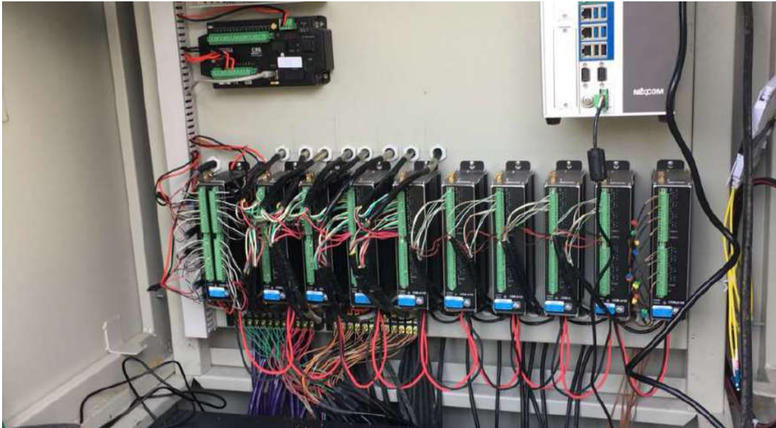
รูปที่ 5.102 การติดตั้งอุปกรณ์บันทึกข้อมูล (Data Logger) แปลงโครงสร้างถนนลาดยาง
