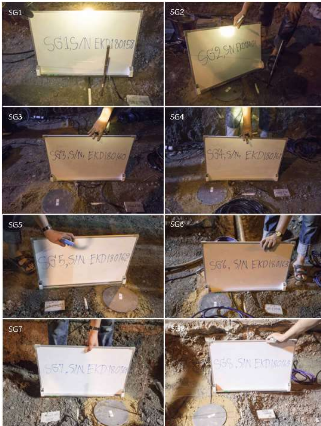
รูปที่ 5.22 งานติดตั้งอุปกรณ์ตรวจวัดความเครียด (Strain Gage) ในชั้น Subgrade
