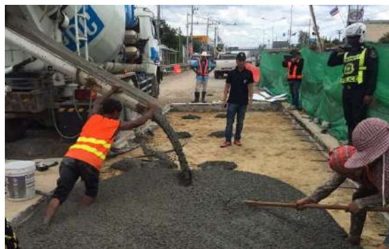
รูปที่ 5.47 เทคอนกรีตกำลังอัดสูง (High Strength Concrete) สำหรับผิวทางคอนกรีต
