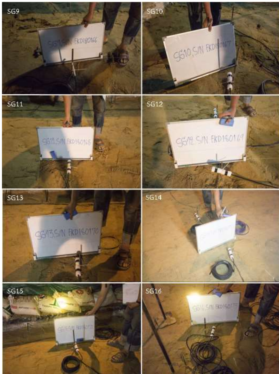
รูปที่ 5.32 งานติดตั้งอุปกรณ์ตรวจวัดความเครียด (Strain Gage) ในชั้น RC Surface
