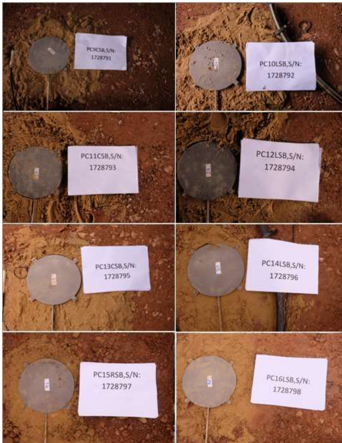
รูปที่ 5.85 งานติดตั้งอุปกรณ์ตรวจวัดค่าแรงดัน (Pressure Cell) ในชั้น Base
