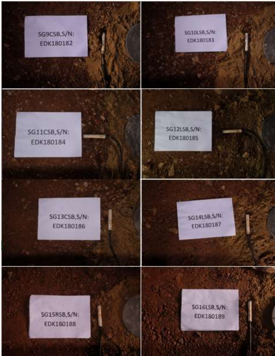
รูปที่ 5.84 งานติดตั้งอุปกรณ์ตรวจวัดความเครียด (Strain Gage) ในชั้น Base
