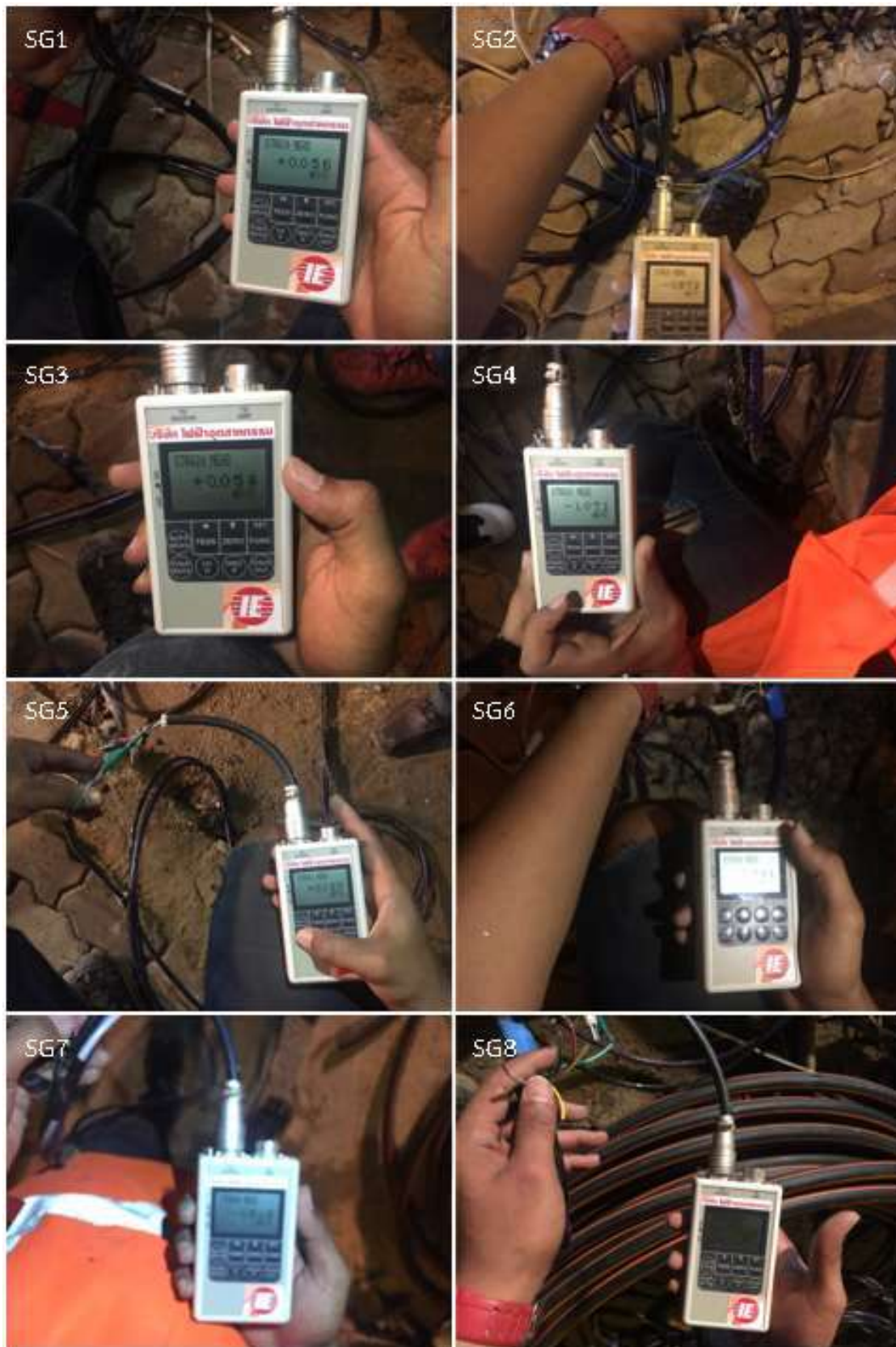
รูปที่ 5.25 งานทดสอบสัญญาณอุปกรณ์ตรวจวัดความเครียด (Strain Gage) ในชั้น Subgrade
