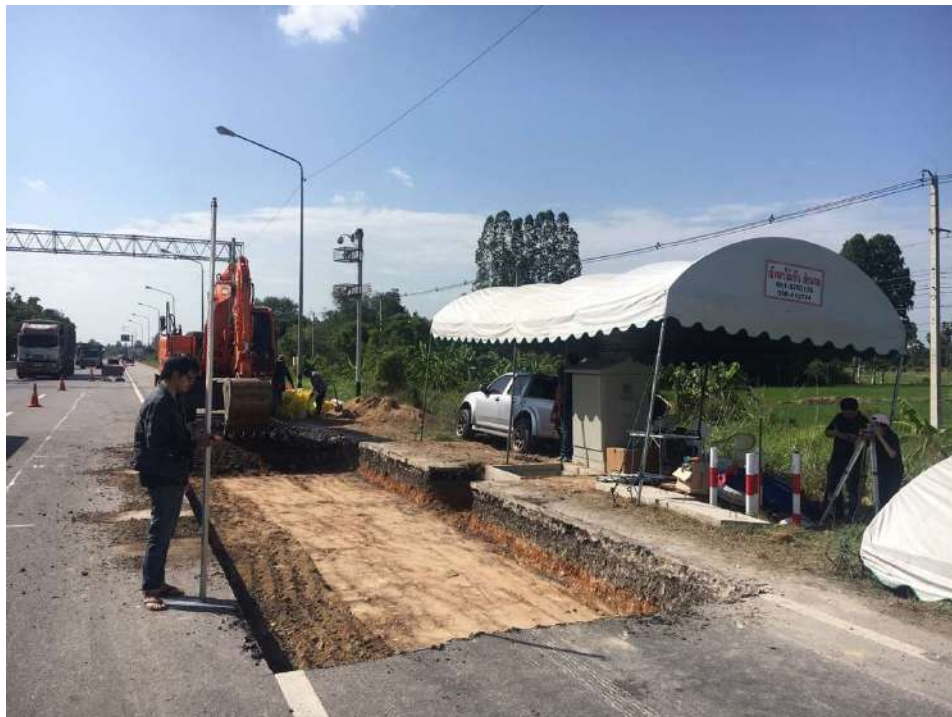
รูปที่ 5.125 งานตรวจสอบระดับชั้น Subgrade
