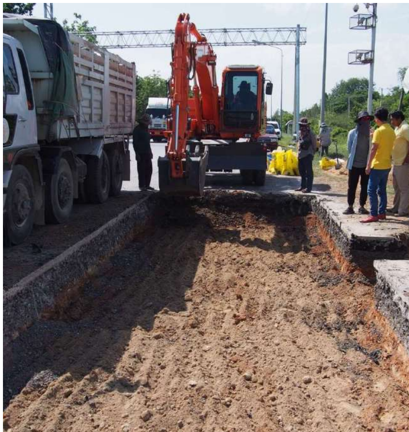
รูปที่ 5.123 งานขุดรื้อโครงสร้างชั้นทางจนถึงชั้น Subgrade
