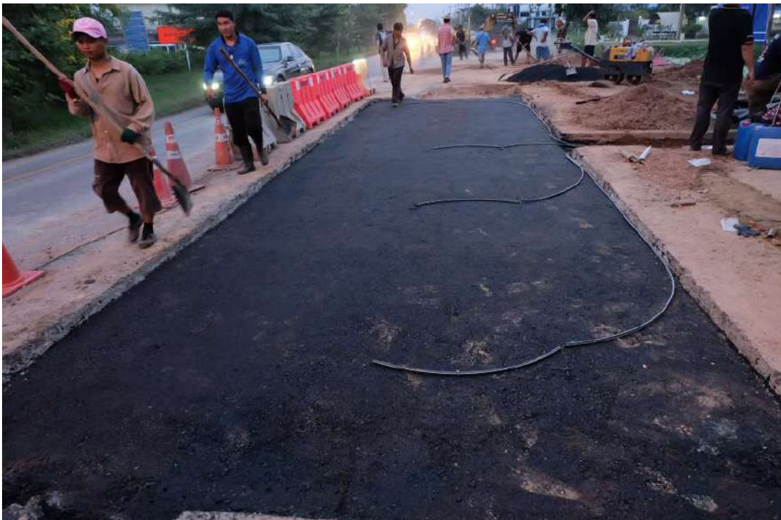
รูปที่ 5.95 งานเดินสายสัญญาณของอุปกรณ์ตรวจวัดค่าอุณหภูมิ (Thermocouple) ในชั้น AC Surface ลงท่อ PE
