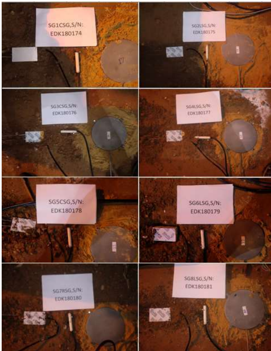
รูปที่ 5.78 งานติดตั้งอุปกรณ์ตรวจวัดความเครียด (Strain Gage) ในชั้น Subgrade
