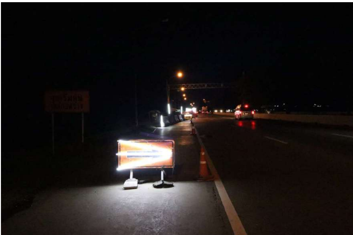
รูปที่ 5.118 การติดตั้งไฟแสงสว่างและไฟสัญญาณจราจรในเวลากลางคืน
