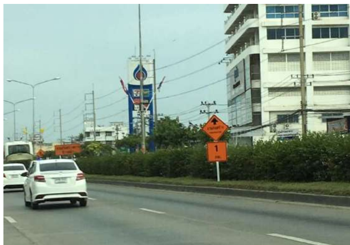
รูปที่ 5.7 การติดตั้งป้ายจราจรสำหรับแปลงตรวจวัดโครงสร้างถนนคอนกรีต
