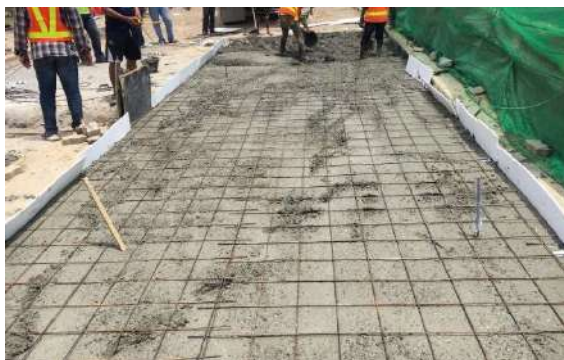
รูปที่ 5.49 การติดตั้งเหล็กเสริมกันแตก (Wire Mesh)
