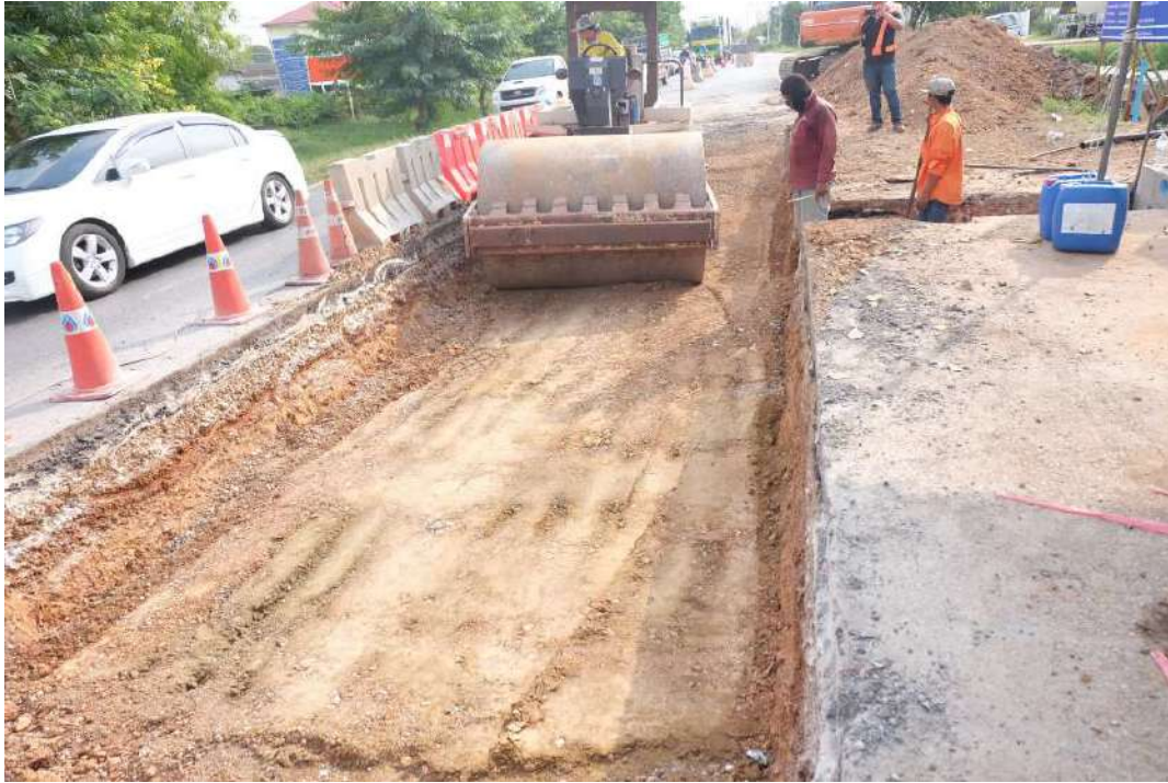
รูปที่ 5.73 งานบดอัดชั้น Subgrade
