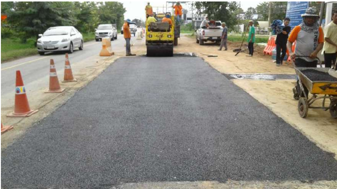
รูปที่ 5.99 ชั้น Asphalt Concrete Wearing Course
