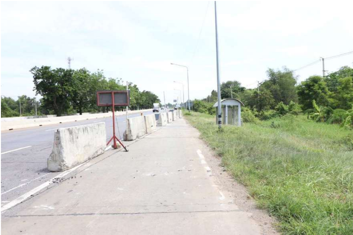
รูปที่ 5.117 การปิดการจราจร 1 ช่องทางซ้ายสุดสำหรับแปลงตรวจวัดโครงสร้างถนนลาดยาง
