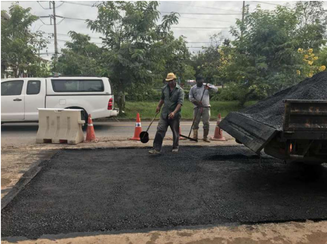
รูปที่ 5.98 ชั้น Tack Coat
