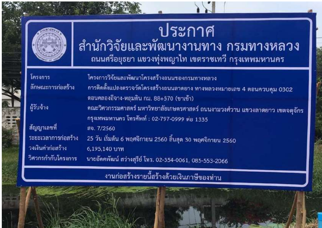
รูปที่ 5.66 ป้ายประชาสัมพันธ์โครงการระหว่างติดตั้งสำหรับแปลงตรวจวัดโครงสร้างถนนลาดยาง
