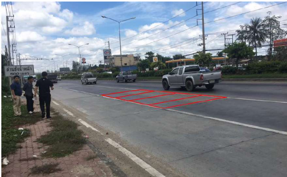
รูปที่ 4.5 บริเวณแปลงโครงสร้างถนนคอนกรีตก่อนถึงบริเวณเครื่องชั่ง WIM นครชัยศรี (ขาเข้า)
