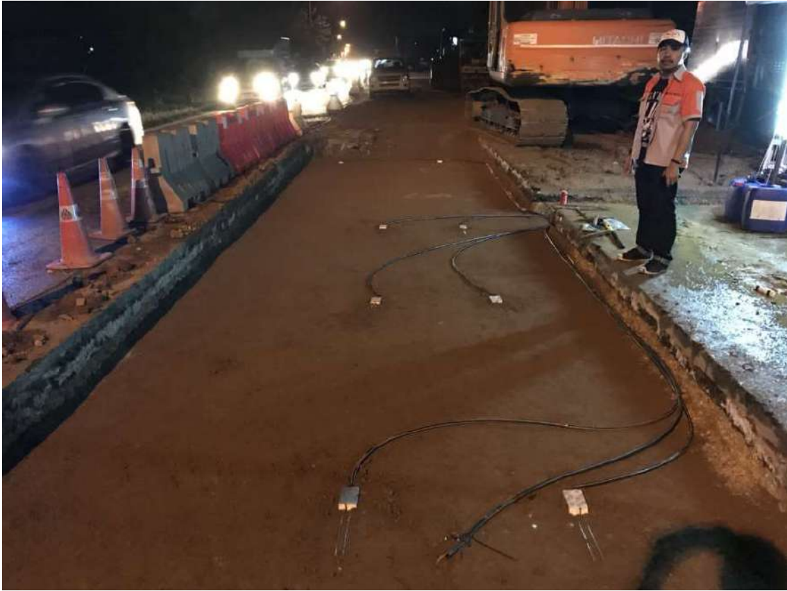
รูปที่ 5.90 งานเดินสายสัญญาณของอุปกรณ์ตรวจวัด ในชั้น Middlebase ลงท่อ PE
