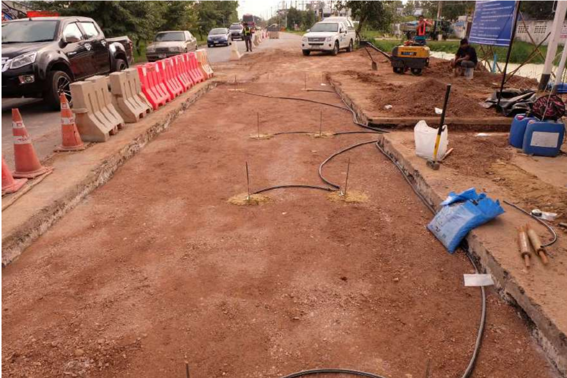
รูปที่ 5.94 งานเดินสายสัญญาณของอุปกรณ์ตรวจวัดค่าความเครียดสำหรับผิวทางลาดยาง (Asphalt Strain Gage) ในชั้น AC Surface ลงท่อ PE
