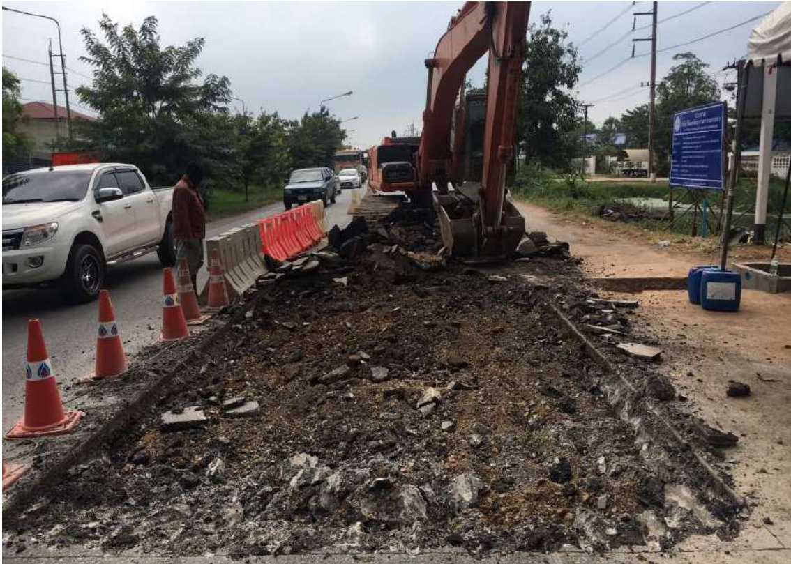
รูปที่ 5.71 งานขุดรื้อผิวทางและโครงสร้างชั้นทางช่องจราจรที่ 1
