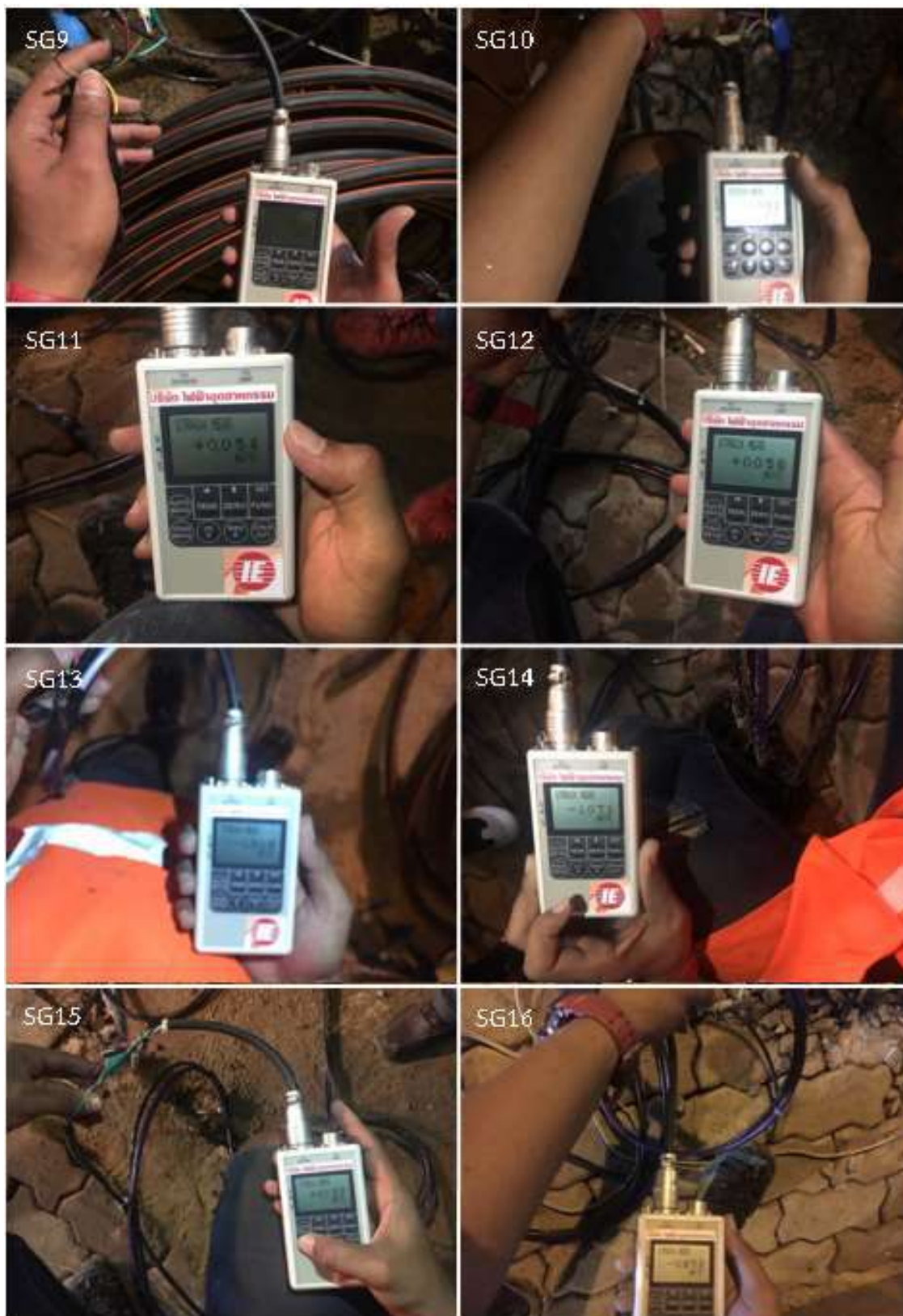
รูปที่ 5.35 งานทดสอบสัญญาณอุปกรณ์ตรวจวัดความเครียด (Strain Gage) ในชั้น RC Surface
