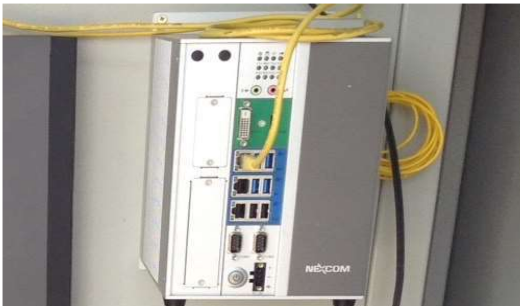
รูปที่ 5.64 การติดตั้งหน่วยประมวลผลภาคสนามแปลงตรวจวัดโครงสร้างถนนคอนกรีต
