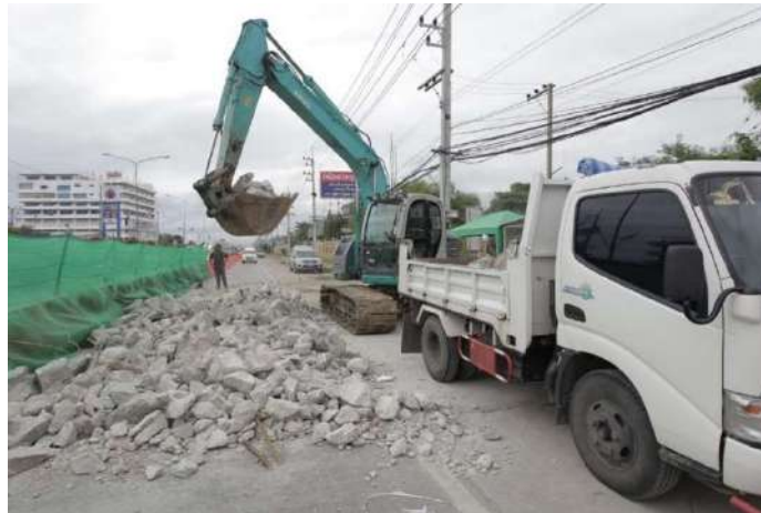
รูปที่ 5.12 งานขุดย้ายผิวทางคอนกรีตออกไปทิ้ง
