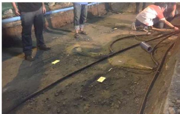
รูปที่ 5.28 งานเดินสายสัญญาณของอุปกรณ์ตรวจวัดจำนวน 24 ตัว ในชั้น Subgrade ลงท่อ PE
