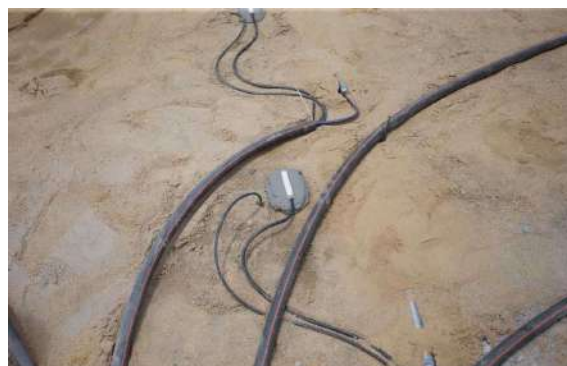
รูปที่ 5.38 งานเดินสายสัญญาณของอุปกรณ์ตรวจวัด ในชั้น RC Surface ลงท่อ PE
