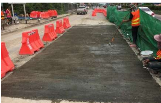
รูปที่ 5.51 ทาน้ำยาบ่มคอนกรีตบนผิวคอนกรีต
