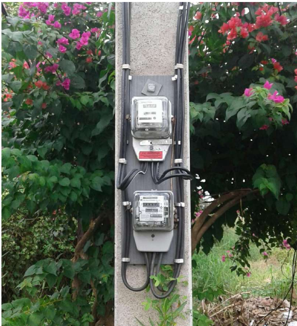
รูปที่ 5.105 ระบบไฟฟ้าแปลงตรวจวัดโครงสร้างถนนลาดยาง
