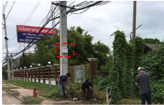
รูปที่ 5.59 ระบบไฟฟ้าแปลงตรวจวัดโครงสร้างถนนคอนกรีต
