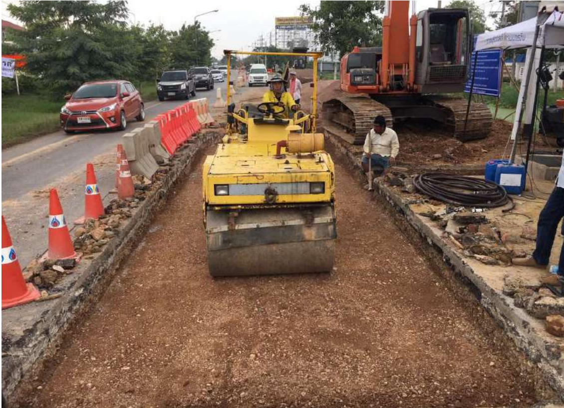
รูปที่ 5.82 การฝังกลบชั้น Subbase, Selected Material และ Subbase
