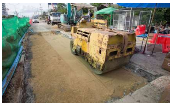
รูปที่ 5.30 การฝังกลบชั้น Subbase ด้วยวัสดุ Sand Cushion สำหรับรองพื้นถนนคอนกรีต
