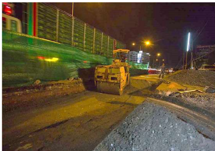
รูปที่ 5.18 งานบดอัดชั้น Subgrade เดิม
