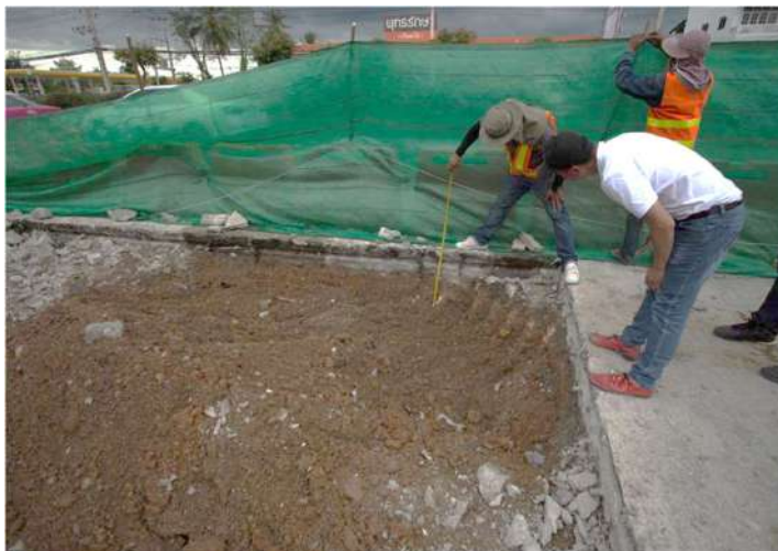
รูปที่ 5.14 งานขุดรื้อชั้น Sand Cushion, Subbase, Selected Material จนถึงชั้น Subgrade (2)
