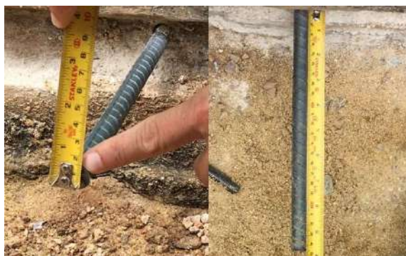
รูปที่ 5.43 ติดตั้งเหล็กยึด (Tie Bar) ขนาด 16 มม. ฝังในรอยต่อตามขวางของถนน ด้านละ 25 ซม.
