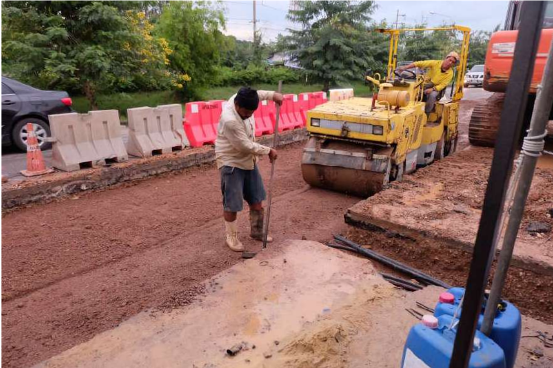
รูปที่ 5.87 การฝังกลบชั้น Subbase จนถึงชั้น Middlebase
