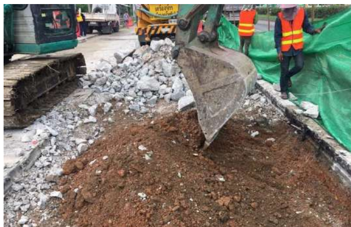
รูปที่ 5.13 งานขุดรื้อชั้น Sand Cushion, Subbase, Selected Material จนถึงชั้น Subgrade (1)
