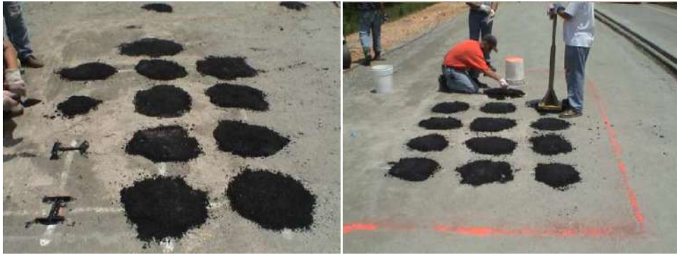
รูปที่ 3.10 ตัวอย่างการกลบ Asphalt Strain Gauge
