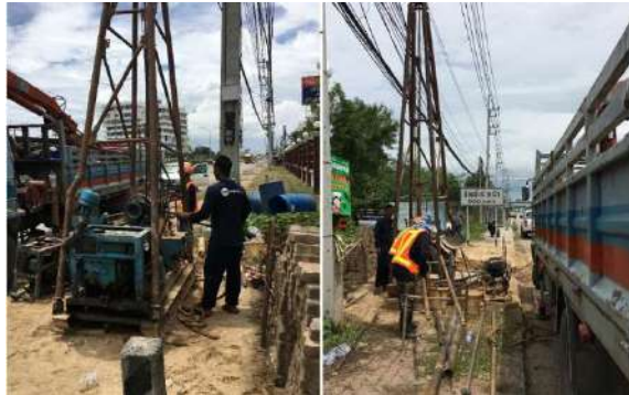
รูปที่ 5.53 ขุดหลุมเจาะ ลึกขนาด 15 เมตร จำนวน 2 จุด แปลงตรวจวัดโครงสร้างถนนคอนกรีต
