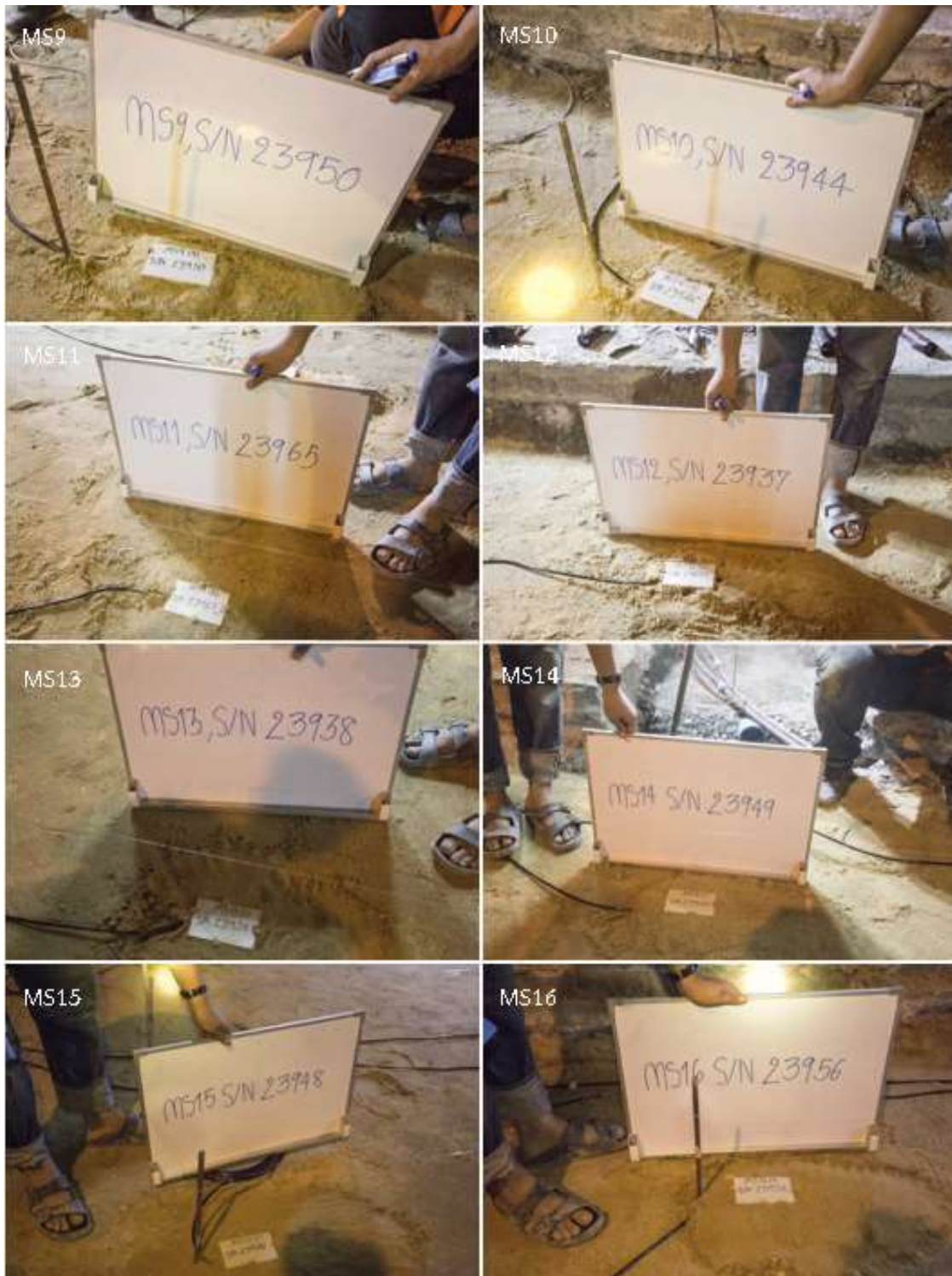
รูปที่ 5.34 งานติดตั้งอุปกรณ์ตรวจวัดความชื้น (Moisture Sensor) ในชั้น RC Surface
