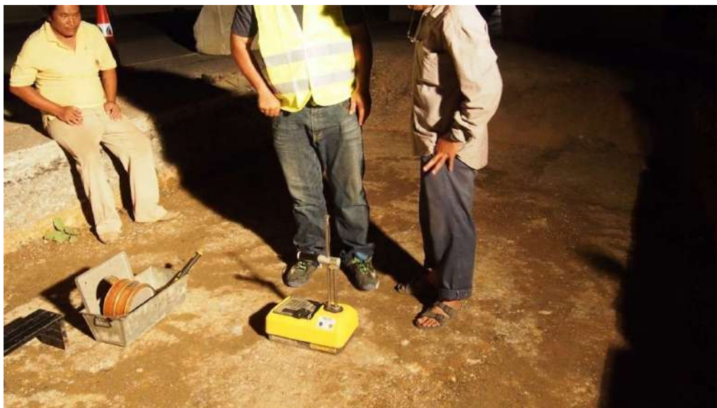
รูปที่ 5.127 การตรวจสอบค่าการบดอัดด้วยเครื่อง Nuclear Density Gage ในชั้น Subgrade
