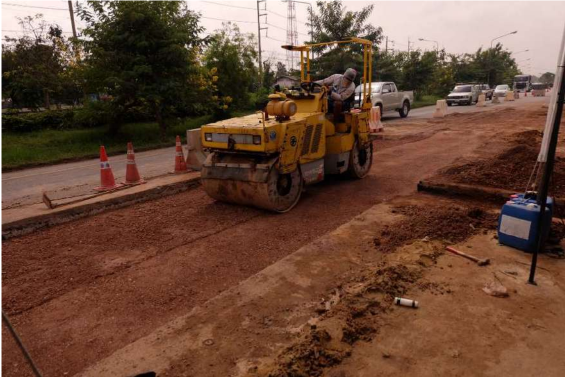
รูปที่ 5.91 การฝังกลบชั้น Middlebase จนถึงชั้น Under AC Surface
