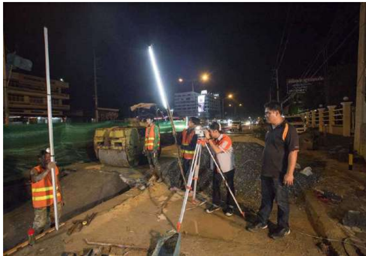
รูปที่ 5.17 งานตรวจสอบระดับชั้น Subgrade เดิม
