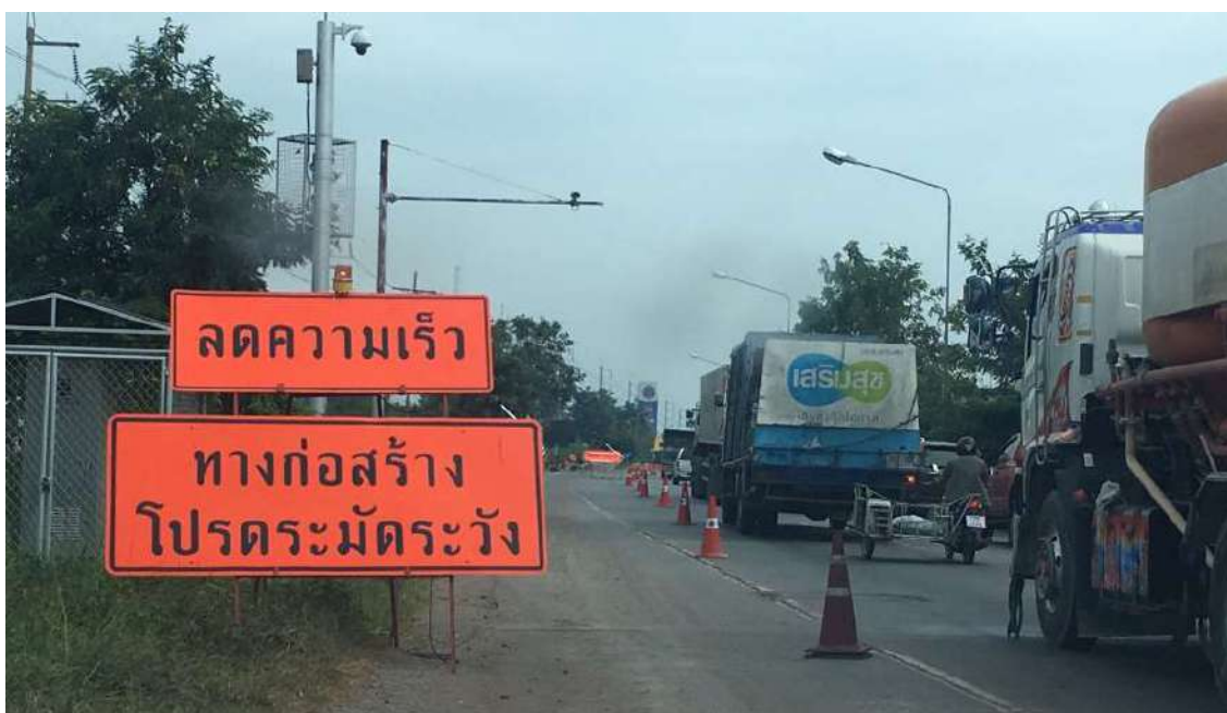
รูปที่ 5.69 การติดตั้งป้ายจราจรสำหรับแปลงตรวจวัดโครงสร้างถนนลาดยาง
