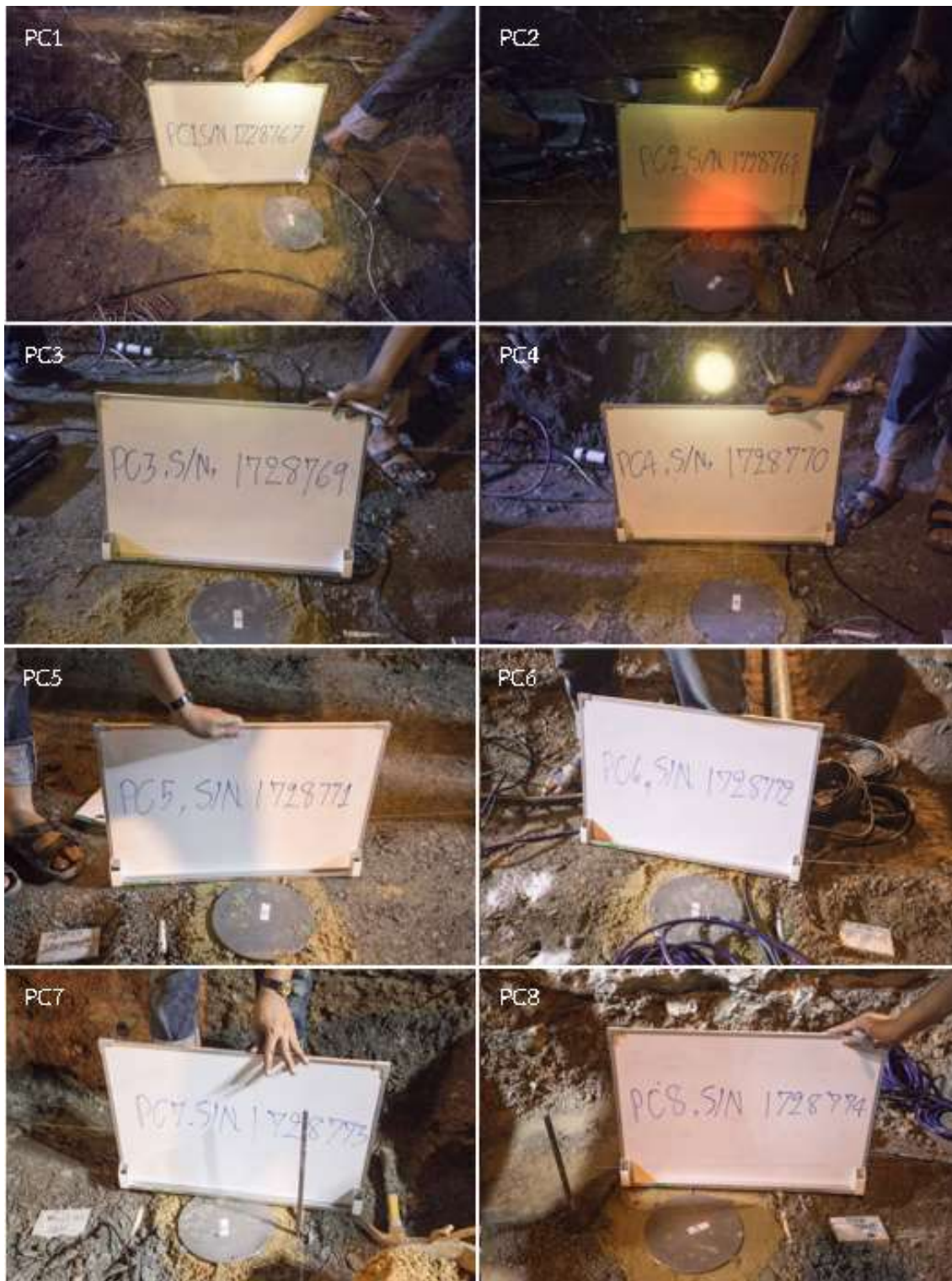
รูปที่ 5.23 งานติดตั้งอุปกรณ์ตรวจวัดค่าแรงดัน (Pressure Cell) ในชั้น Subgrade
