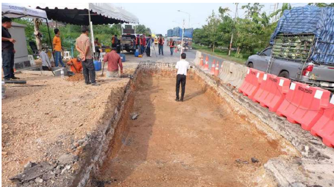
รูปที่ 5.74 งานตรวจสอบระดับชั้น Subgrade
