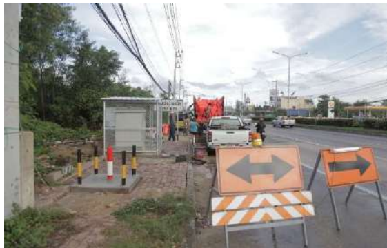
รูปที่ 5.55 เทพื้นคอนกรีตบริเวณรอบหลุมเจาะแปลงตรวจวัดโครงสร้างถนนคอนกรีต
