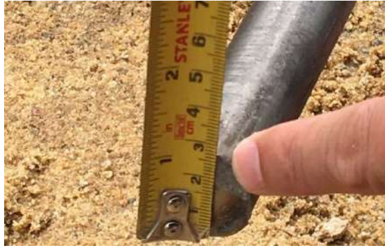
รูปที่ 5.39 ติดตั้งเหล็กเดือย (Dowel Bar) ขนาด 25 มม.
