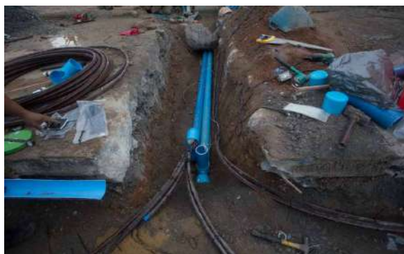
รูปที่ 5.29 งานเดินสายสัญญาณจากท่อ PE เข้าสู่ท่อหลัก (Main Pipe) และตู้ควบคุม (Control Panel)
