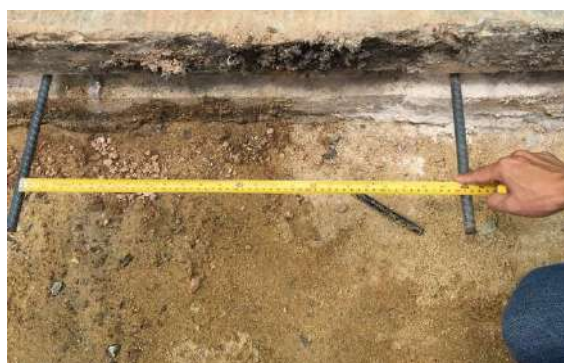
รูปที่ 5.44 ติดตั้งเหล็กยึด (Tie Bar) ฝังในรอยต่อตามขวางของถนน ระยะห่างที่ 60 ซม.
