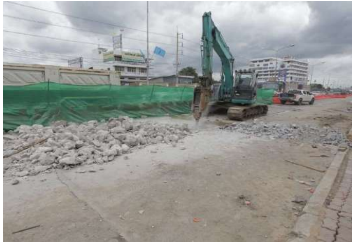
รูปที่ 5.11 งานเจาะสกัดรื้อผิวทางคอนกรีต บริเวณช่องจราจรที่ 2
